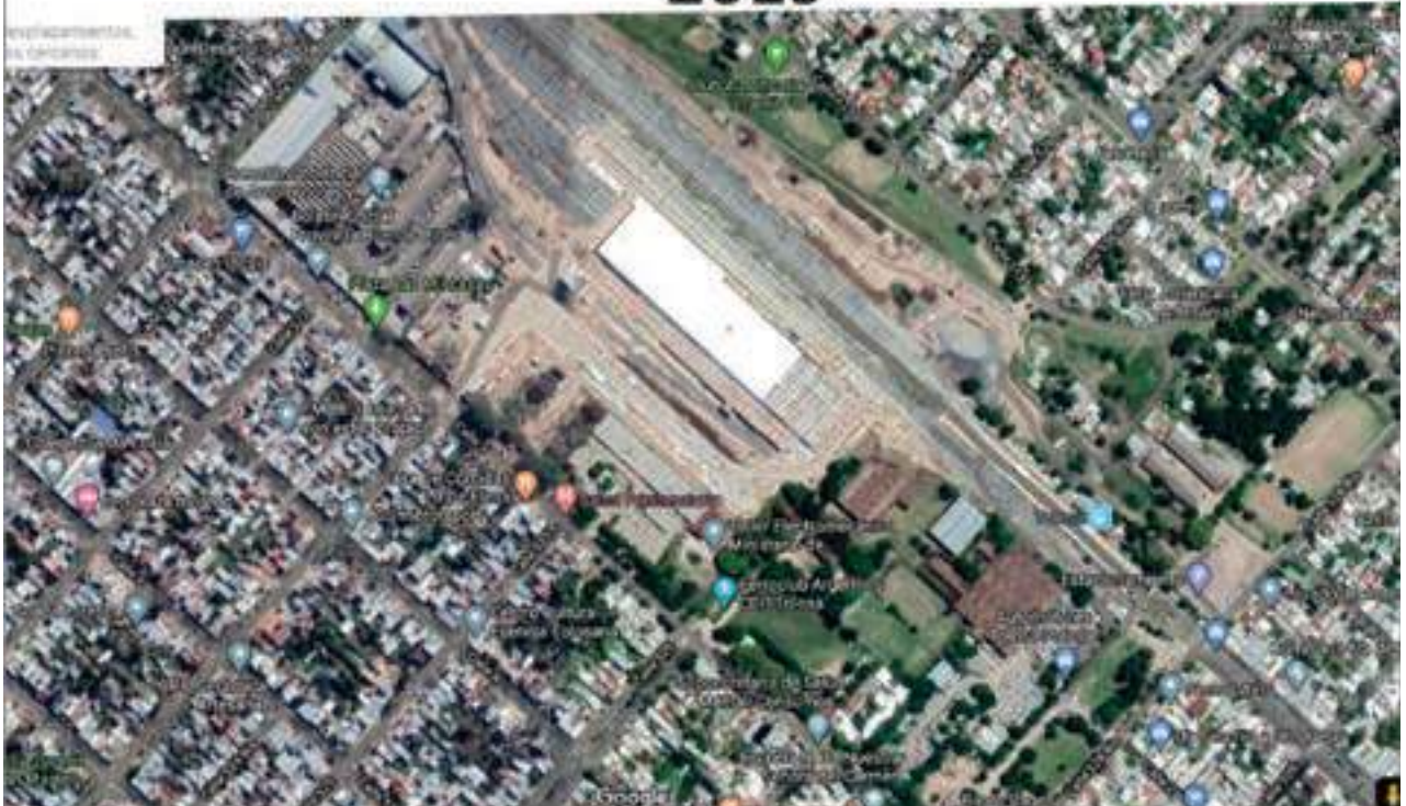
Fotos aérea del Google Maps entre 2016 - 2019 : Muestra la transformación del patrimonio industrial con la demolición del galpón destinado a carpintería y que luego sería el taller de reparación de trenes de Roca.
