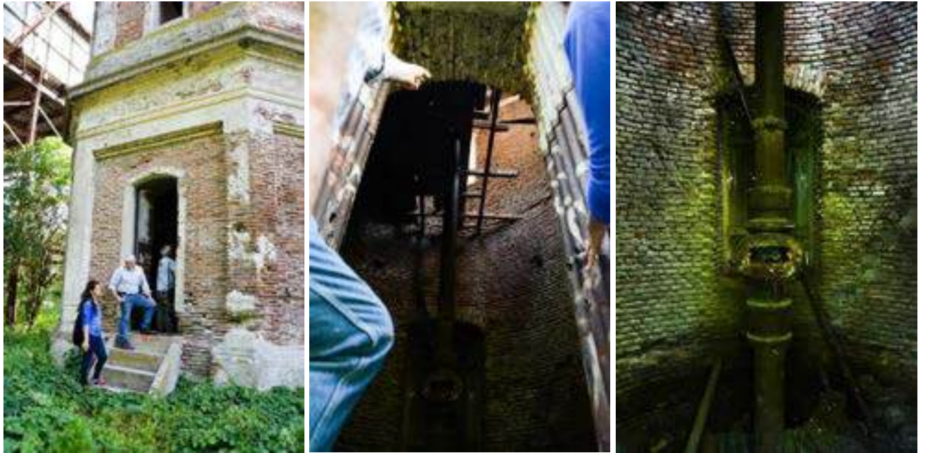
Pie de la torre-tanque con vista al hueco por donde se desarrollaba la escalera caracol que ascendía hasta el punto más alto de la torre
