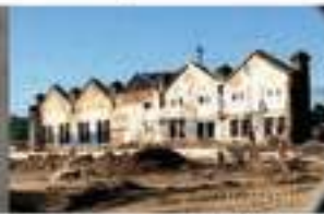
GALPONES DEMOLIDOS EN TOLOSA
