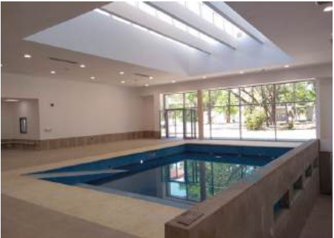
Fig. 8.2.3 Cubierta tipo shead en grandes espacios para permitir el ingreso de luz natural en forma indirecta.
