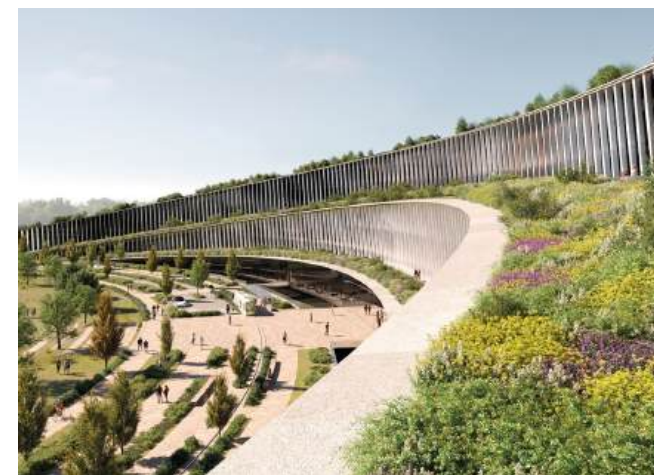
Fig. 5.7.6 Imagen de la morfología curva y escalonada en articulación con el parque.
