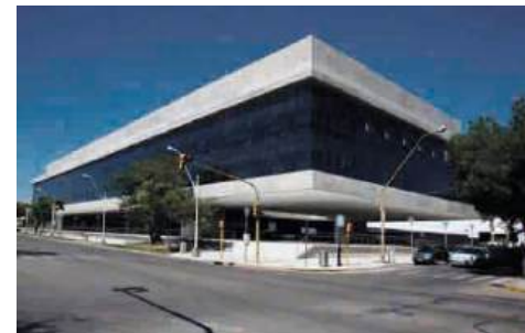
Fig. 1.3.3 y 1.3.4 En estas fotos se puede ver como la resolución estructural permite liberar y retirar la planta baja generando el espacio semicubierto que sirve de transición para los ingresos principales del edificio.
