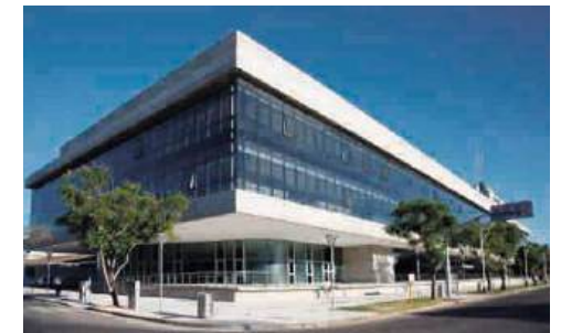
Fig. 1.3.3 y 1.3.4 En estas fotos se puede ver como la resolución estructural permite liberar y retirar la planta baja generando el espacio semicubierto que sirve de transición para los ingresos principales del edificio.
