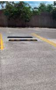
Fig. 8.4.3 Pavimento de concreto permeable que se utilizó en el estacionamiento.
