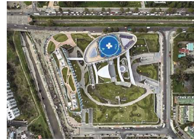
Fig. 4.8.2 Foto aérea donde se ve la torre ya construida y la pisada de la futura torre.
