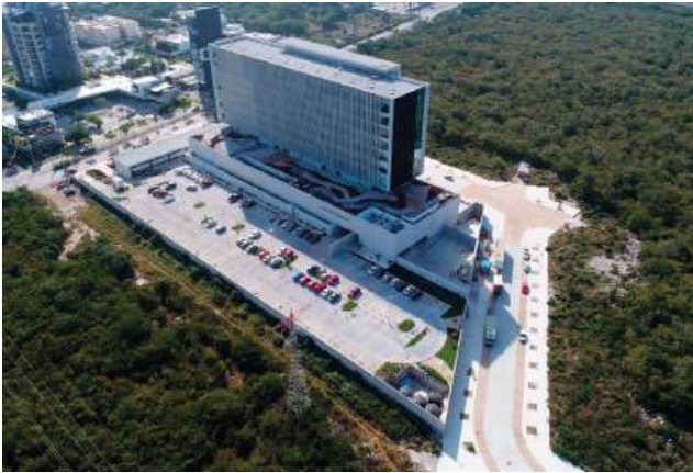
Fig. 8.4.2 Foto aérea donde se pueden ver el basamento horizontal y la placa vertical, la fachada corta orientada al oeste, y la fachada larga orientada al sur, con poca exposición solar y vidriada en gran parte.
