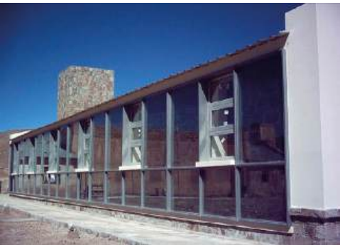
Fig. 8.5.2 y 8.5.3 Vistas de los muros colectores-almacenadores también conocidos como muro Trombe.
