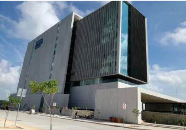
Fig. 8.4.1 Fachada larga orientada al sur, de mayor exposición solar, en gran parte ciega y con parasoles de hormigón premoldeado
