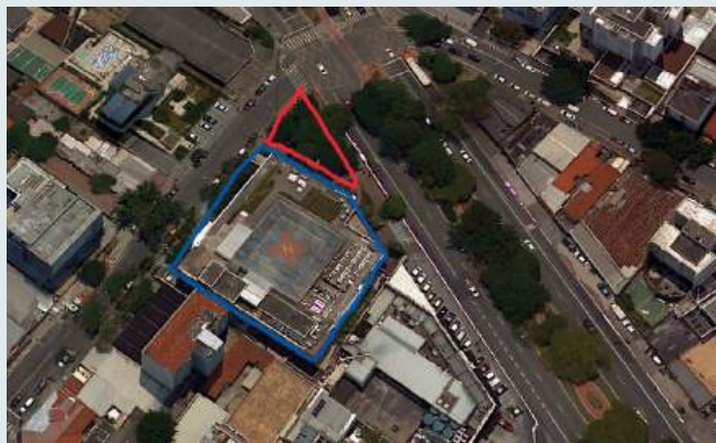
Fig. 1.5.1 Vista aérea donde se puede ver el edificio que ocupa prácticamente la totalidad del lote dejando libre solamente un sector de la esquina donde se cruzan las dos vías vehiculares.
