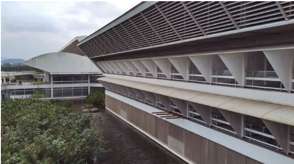
Fig. 6.3.3 Foto lateral donde se ve el entresuelo, con un cierre de persianas o celosías verticales, debajo del edificio.
