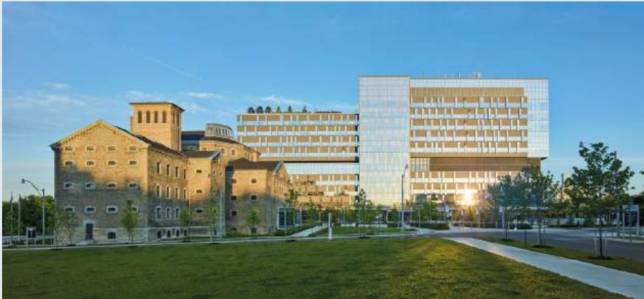
Fig. 2.8.1 Foto exterior del edificio.
