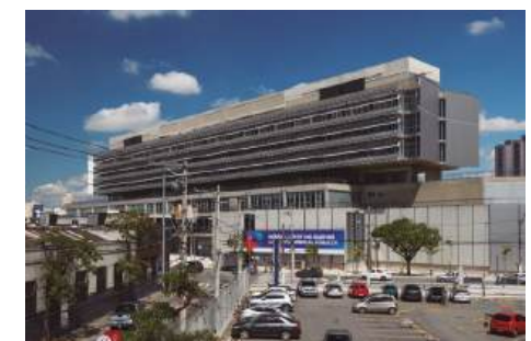
Fig. 3.5.8 Vista exterior donde se puede ver la placa con la internación sobre el basamento que contiene al resto de los servicios, y la sombra producida por la planta de transición.
