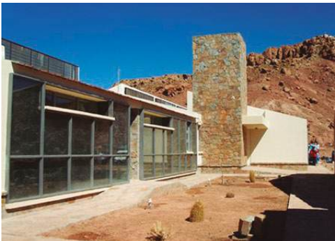
Fig. 8.5.2 y 8.5.3 Vistas de los muros colectores-almacenadores también conocidos como muro Trombe.
