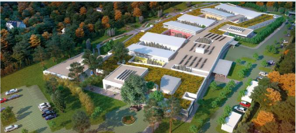
Fig. 8.2.1 Vista aérea del edificio donde se puede apreciar el techo verde.
