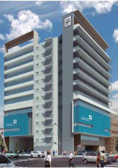
Fig. 1.6.4 Vista de una de las esquinas de la manzana donde se pueden apreciar el frente del sanatorio sobre dos calles diferentes con un edificio de otro uso entre ambos. La planta baja sobre la avenida (izquierda) se rehunde de manera tal de indicar claramente la situación de ingreso y generar un espacio semicubierto de transición y protegido para quien llega o se retira. En cambio, sobre la calle lateral (derecha), si bien tiene una situación también de ingreso, al tener menor importancia que la principal, se resuelve con una menor jerarquía espacial.
