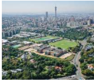
Caso 10.2 Hospital de Niños Nelson Mandela Johannesburg, Sudáfrica Sheppard Robson + John Cooper Architec- ture + GAPP + Ruben 2016
